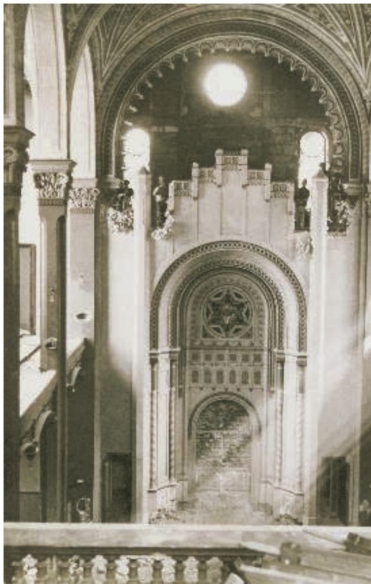
3 Unutrašnjost sinagoge, 1880. Foto: Ivan Standl
